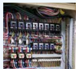
控制盤內機器異常發熱
